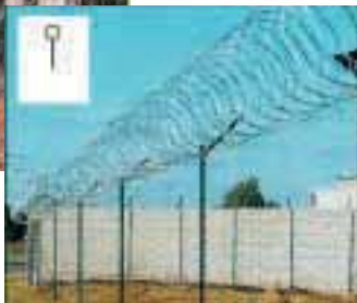
Figuur: Concertina bovenop en / of tegen hekwerk.
